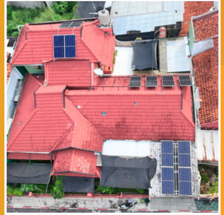
Sukoharjo - Jawa Tengah 12 Panel | 7,4 kWp
